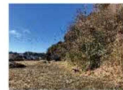
⑦ がけ崩れが発生した形跡
