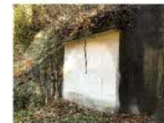
⑩ コンクリートで塞がれた弾庫跡地
